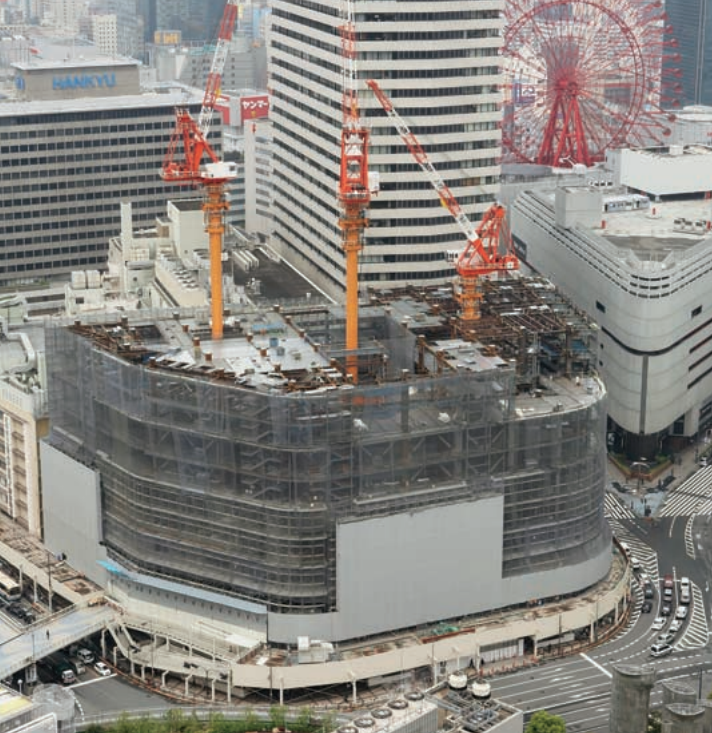
建て替え工事中の阪急百貨店うめだ本店
