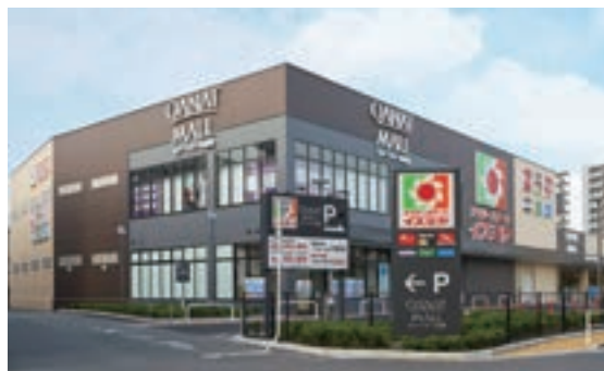
GMS業態から食品スーパーを核とするショッピングモールへと業態変更を行った建て替え第1号店舗「カナートモール住道」
