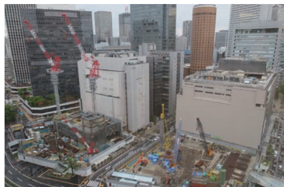
建て替え工事中の阪神梅田本店
