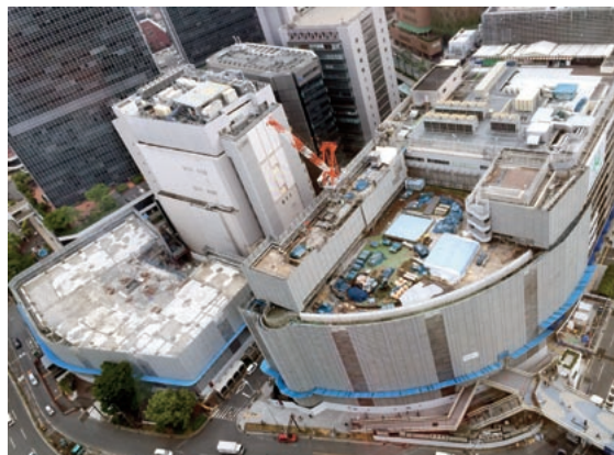
営業を継続しながら建て替え工事中の阪神梅田本店
