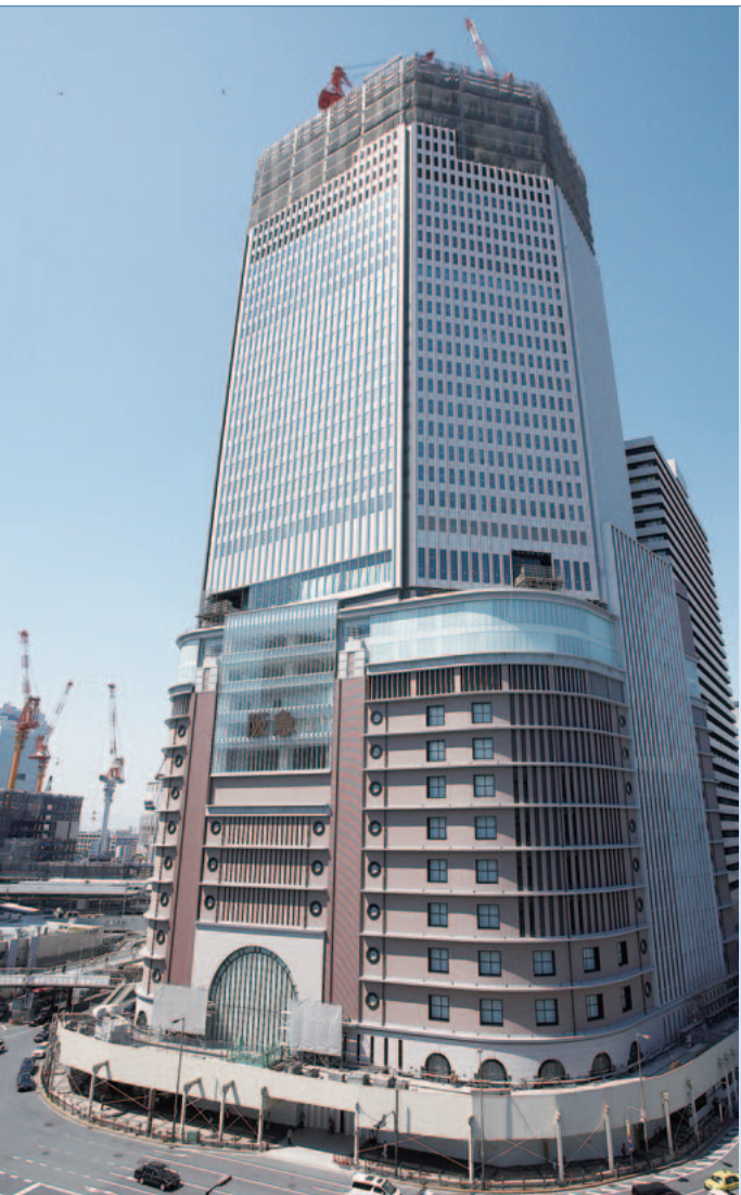
建て替え工事中の阪急百貨店うめだ本店
