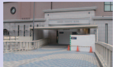
現在工事中の2階入口(5月現在)
