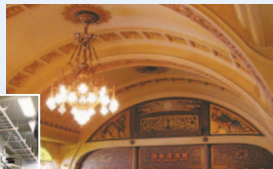
工事前のコンコースと装飾
